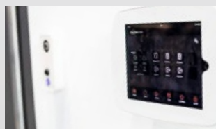
Dispositivi di sicurezza elettrici
