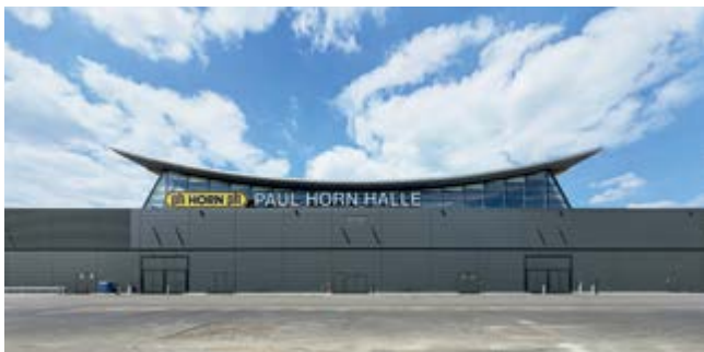
Der Namenszug des Firmengründers der Hartmetall-Werkzeugfabrik Paul Horn GmbH ziert die neue Halle 10 der Messe Stuttgart.
