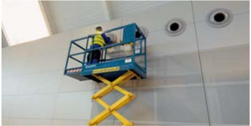
Optimal ausgerichtet: Die Weitwurfdüsen des Lüftungssystems werden von Hand exakt justiert.
