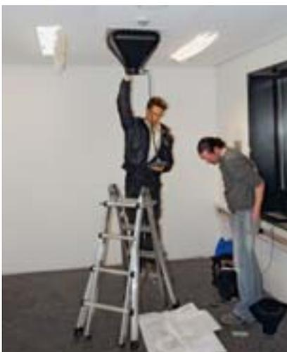
Testbetrieb: Bringt der Lüftungskreislauf auch wirklich das nötige Volumen für diesen Raum?
