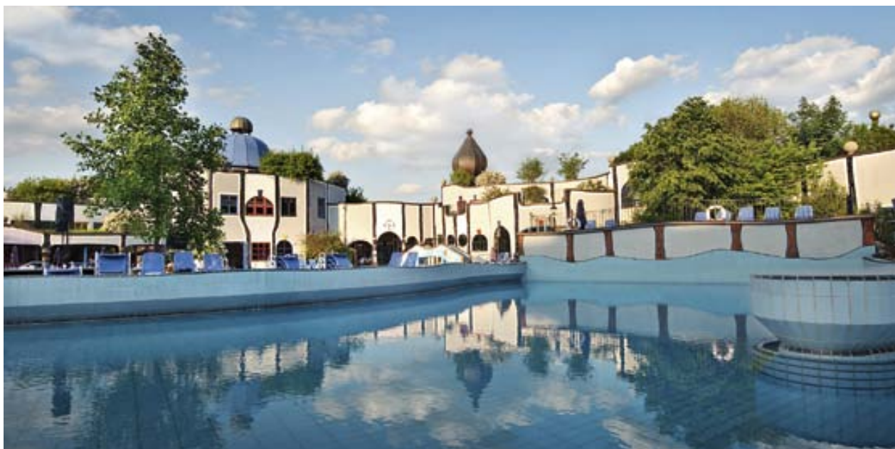
Beim Bau der von Hundertwasser entworfenen Rogner Therme Blumau wurden erstmals primär ökologische Aspekte berücksichtigt.
