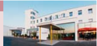
V8 Hotel im ehemaligen Böblinger Airport.
