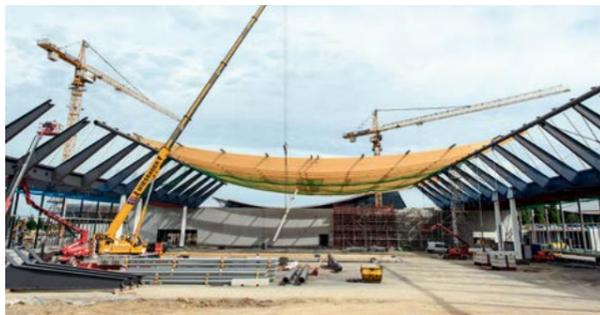
Bilder einer Baustelle: Geschäftsführer, Bauträger und Gesellschafter beim ersten Spatenstich im Januar 2016 (ganz oben). Für das Fundament wurden rund 50.000 Kubikmeter Erdaushub bewegt (rechts). Die 65 Meter langen Brettschichtholzträger für die elegante Dachkonstruktion stammen aus dem Osnabrücker Land.
